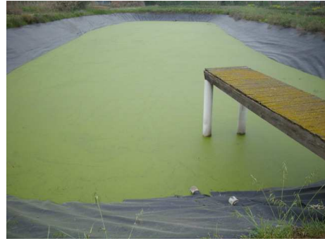
Εικ. 3. Δεξαμενή σταθεροποίησης
