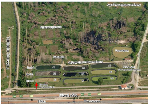
Εικ. 2. Αποψη της πιλοτικής εγκατάστασης δεξαμενών σταθεροποίησης του ΕΘΙΑΓΕ
